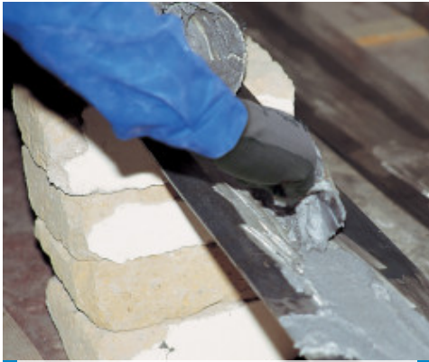
Montering af Adesilex PG1 på en metalplade
