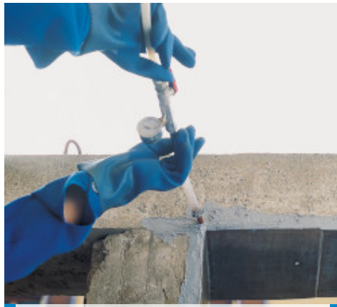
Søjle påføres med Adesilex PG1
