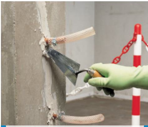
Montering af injektionsrør og tætning af strukturelle sprækker
