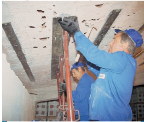
Placering af metalplade til strukturel forstærkning
